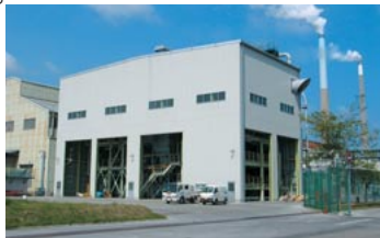
廃プラスチック燃料化施設 第4期プラント
