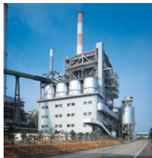
国内有数の発電能力をもつ自家発電設備
