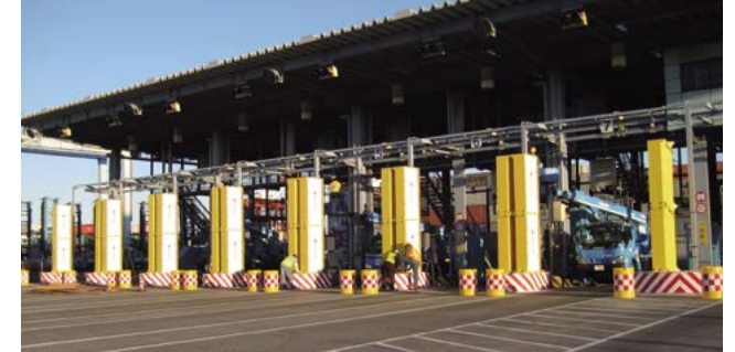
中性子線検出器を用いた核物質検出用のセキュリティゲート
