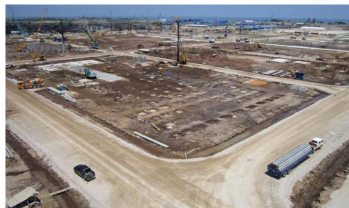
2月に着工した第2期プラント
