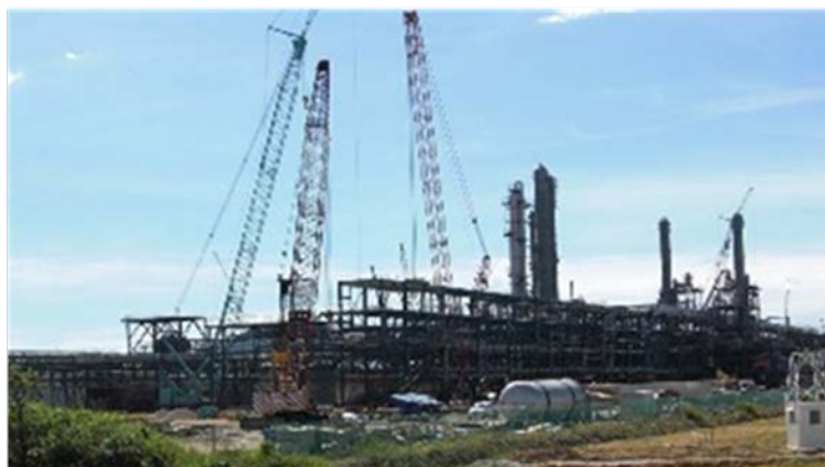
建設が進む第1期プラント
