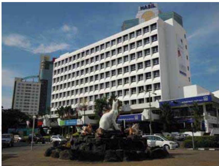
現地事務所が入居しているビル
