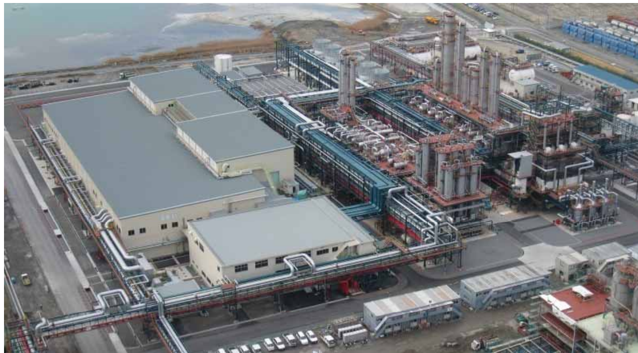
徳山製造所の多結晶シリコンプラント
