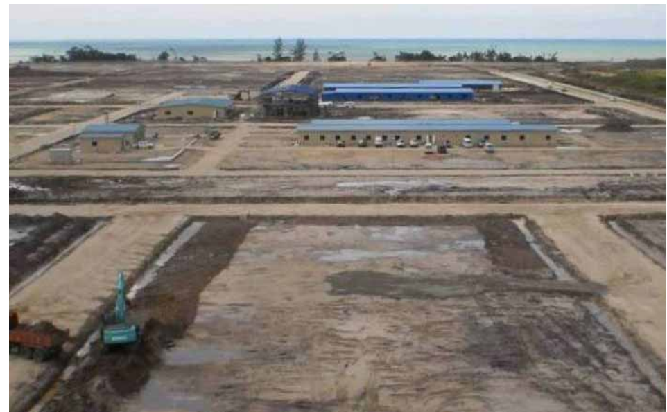
プラント建設が始まった現場 (3/12)
