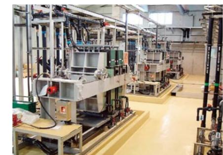
イオン交換膜による高性能透析装置「アシライザー」
