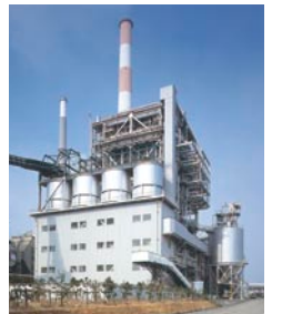
国内有数の発電能力を持つ自家発電設備
