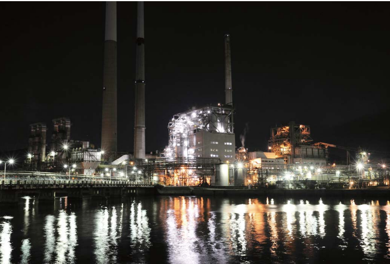
南陽工場から中央発電所を望む
