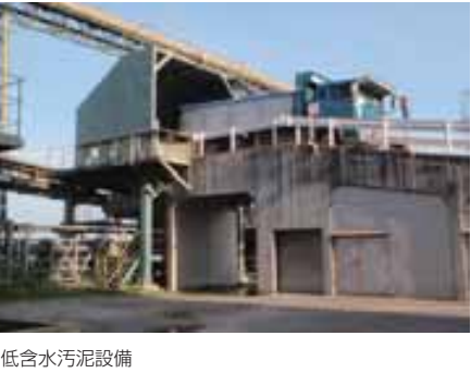
低含水汚泥設備
