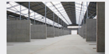
下水道汚泥のバイオマス燃料化
