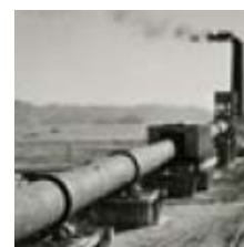
東洋一のセメント湿式法 「マンモスキルン」(長さ185m)
