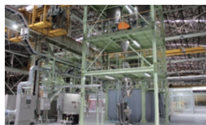
先進技術事業化センター
