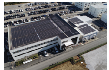
太陽光パネルを設置した鹿島工場の建屋
