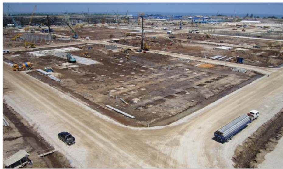
2月に着工した第2期プラント
