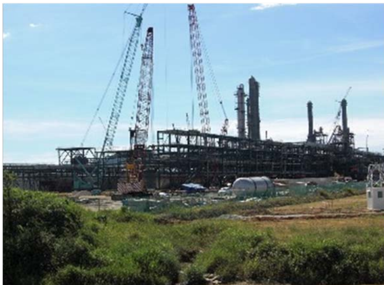
建設が進む第1期プラント
