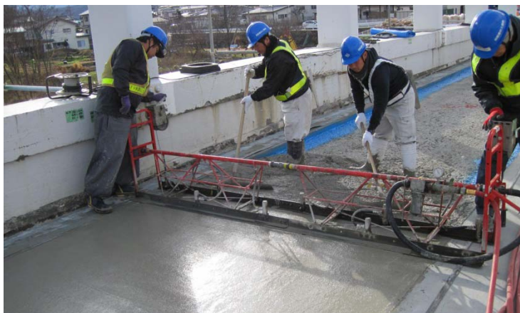
タフスラブ・ラピッド工法による道路橋床版補強の様子
