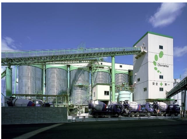
中国生コンクリート
